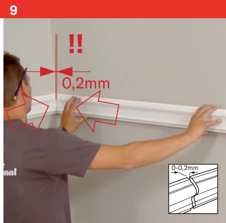
Firmly press together until some adhesive slightly spills out. Do not push all of the glue out of the joint. Maintain a small gap | Duw stevig naar elkaar toe, zonder dat alle lijm uit de voeg wordt gedrukt. Houd een kleine opening over | Pressez fermement. Veillez à ne pas faire sortir toute la colle du joint. Maintenir un petit espace | Aneinander drücken. Achten Sie darauf, nicht den gesamten Kleber aus der Fuge zu drücken. Behalten Sie einen kleinen Spalt bei | Presiona con firmeza. Ten cuidado de no empujar todo el adhesivo fuera de la junta. Mantén una pequeña separación | Premere con forza, senza spingere tutta la colla fuori dalla giunta. Mantenerne una piccola distanza | Mocno docisnij do siebie, nie wypychając całego kleju ze złącza. Zachowaj niewielką szczelinę.
