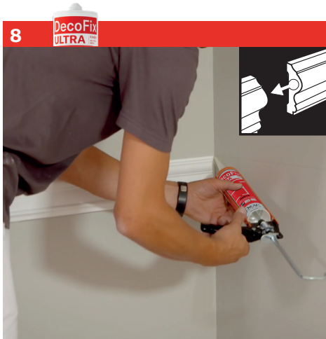
Use DecoFix Ultra in every joint | Gebruik DecoFix Ultra in elke naad | Utilisez DecoFix Ultra pour chaque joint | Verwenden Sie DecoFix Ultra bei jeder Naht | Aplica DecoFix Ultra en todas las juntas | Utilizzare DecoFix Ultra in ogni giunta | Użyj DecoFix Ultra w każdym złączu
