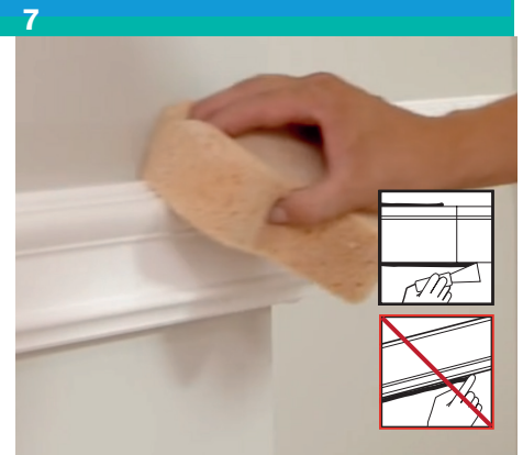
Clean excess adhesive Reinig overtollige lijm Nettoyez l'excédent d'adhésif Überschüssigen Klebstoff reinigen Limpiar el exceso de adhesivo Rimuovere la colla in eccesso Usunąć nadmiar kleju
